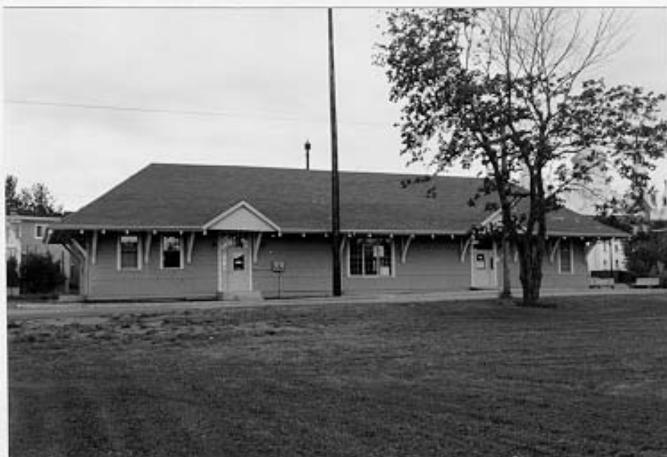
2 Vue arrière de la gare en 1992. (Cliché Ethnotech inc., 1992.)
