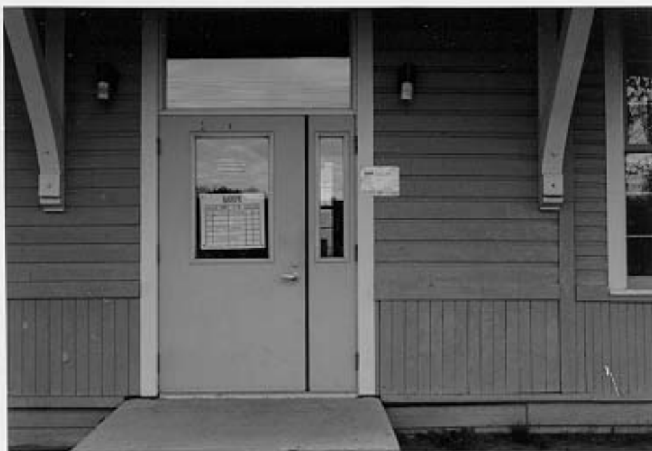
18 Une vue d'une porte d'entrée en métal. (Cliché Ethnotech inc., 1992.)
