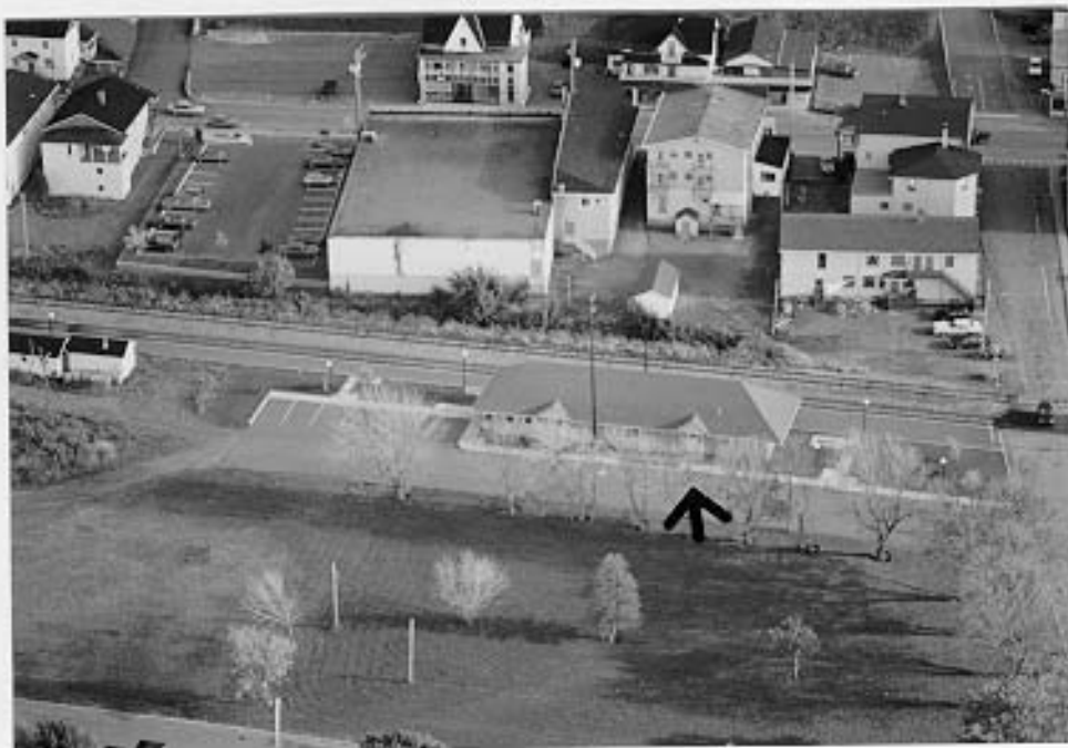
25 Une vue générale du site de la gare en direction ouest. (MAC, Nég. no C.89.379.32.)
