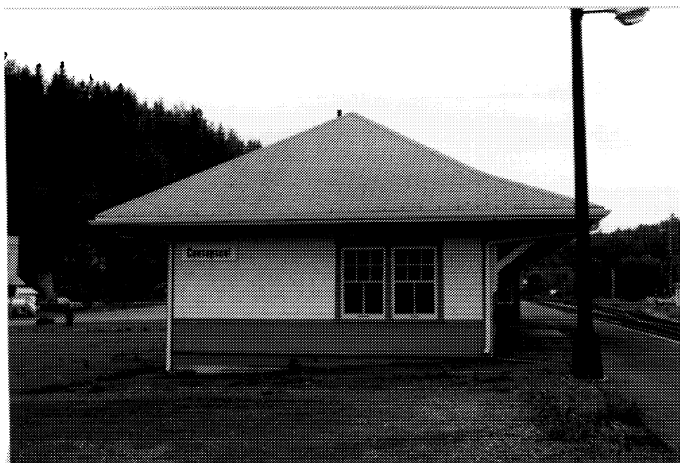
16 Vue de l'extrémité nord de la gare. (Cliché Ethnotech inc., 1992.)
