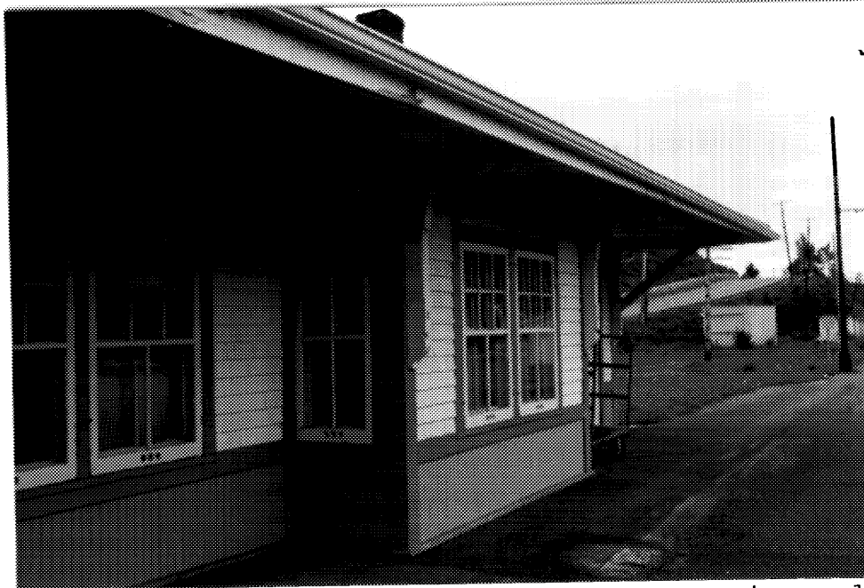
18 Cette saillie du bureau du chef de gare au niveau du rez-de-chaussée constitue l'un des rares éléments d'origine conservés sans altération. (Cliché Ethnotech inc., 1992.)
