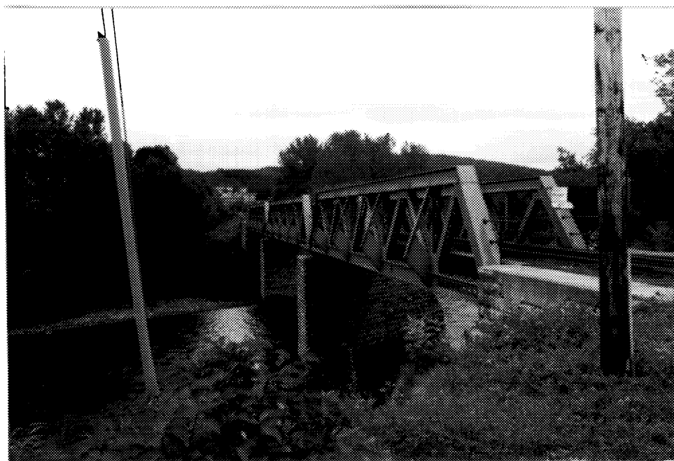
24 Vue du pont situé du côté nord de la gare. (Cliché Ethnotech inc., 1992.)
