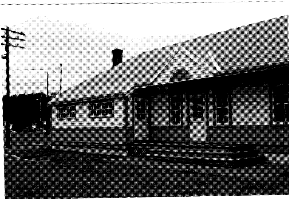
17 Cette entrée arrière de la gare de même que la projection qui se trouve à sa gauche sont le résultat d'interventions récentes. (Cliché Ethnotech inc., 1992.)
