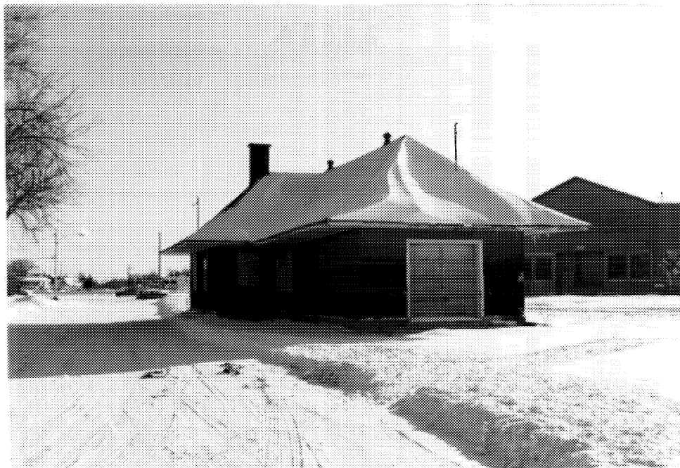
8 Vue de l'extrémité est de la gare. (Cliché Ethnotech inc., 1993.)
