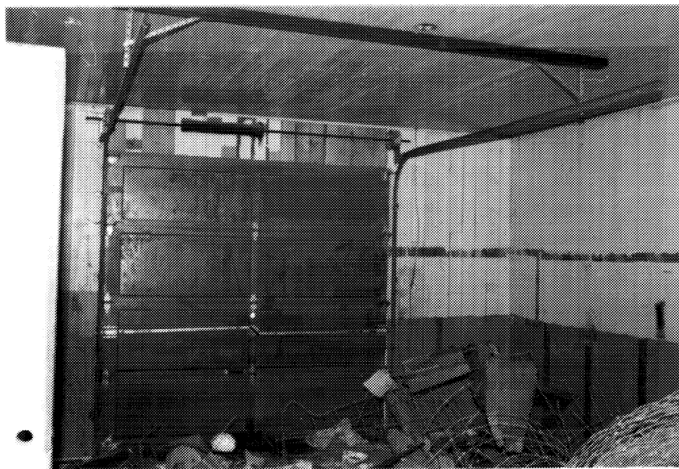
18 Vue de la partie hangar. (Cliché Ethnotech inc., 1993. )
