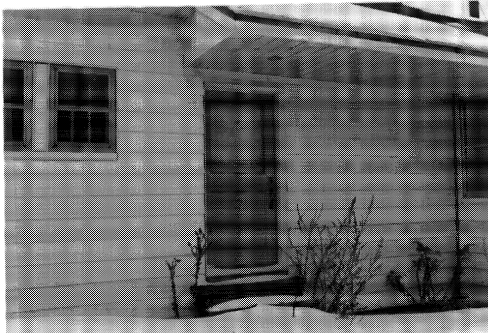
10 Vue de l'entrée principale de la gare. (Cliché Ethnotech inc., 1992. )
