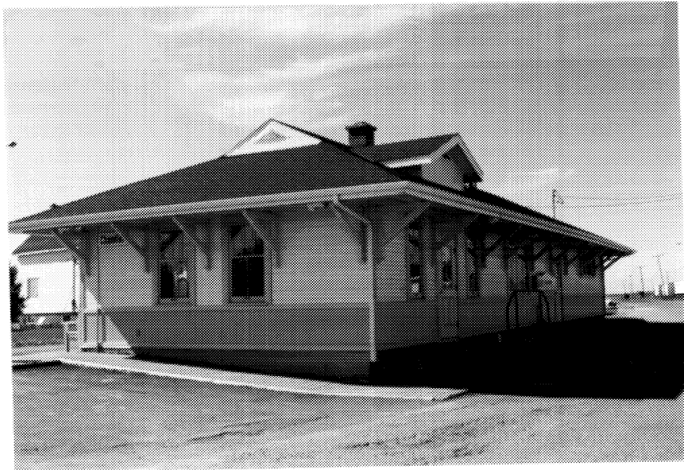
2 Vue arrière de la gare en 1993. (Cliché Ethnotech inc., 1993.)
