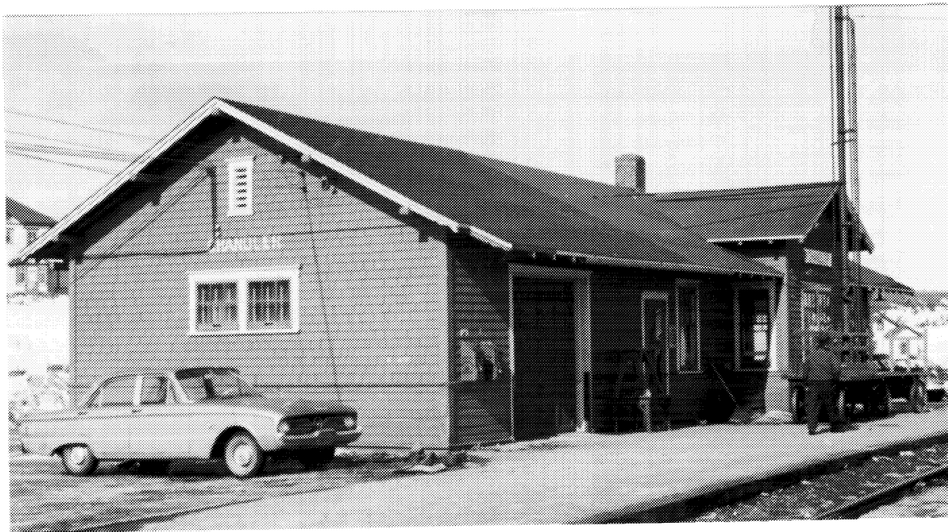
9 Vue de la gare vers 1964. La différence de couleur dans le revêtement du toit trahit l'allongement effectué à cette époque. ( Canadien National, Moncton. )
