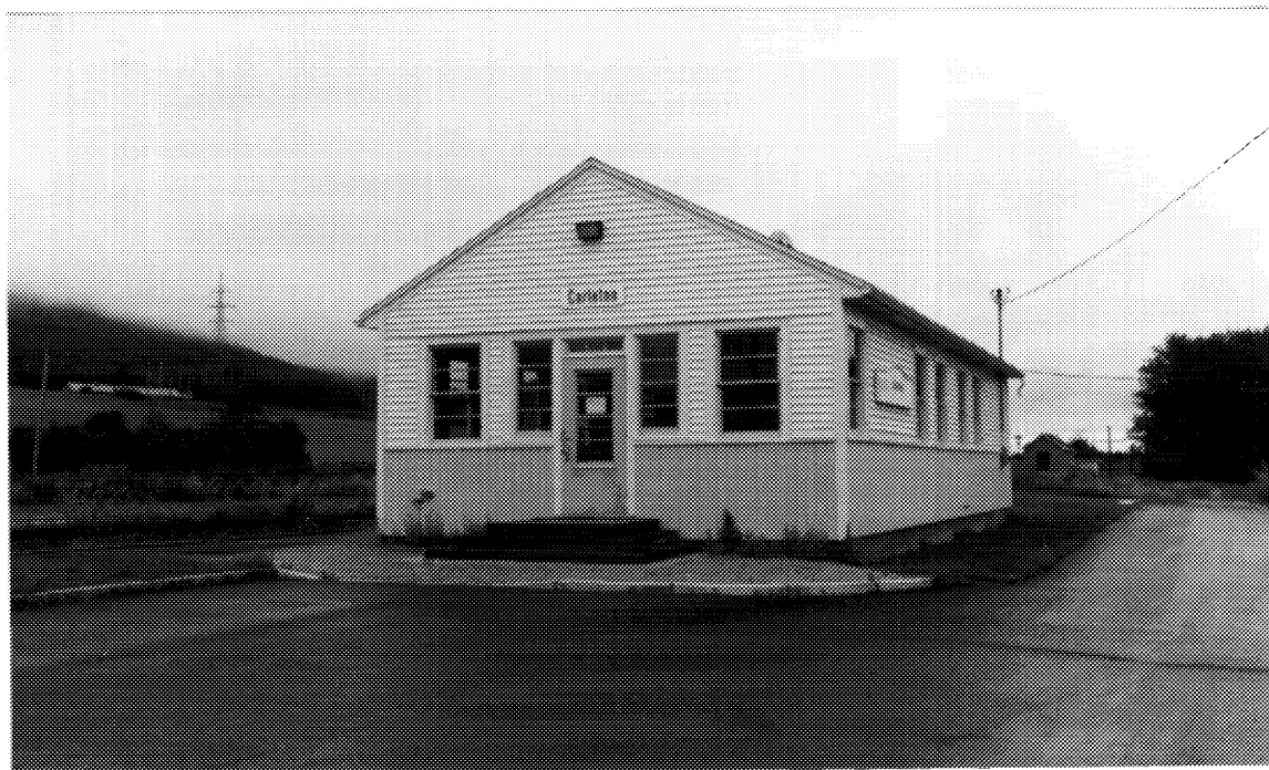
2 Vue arrière de la gare en 1993. (Cliché Ethnotech inc., 1993.)
