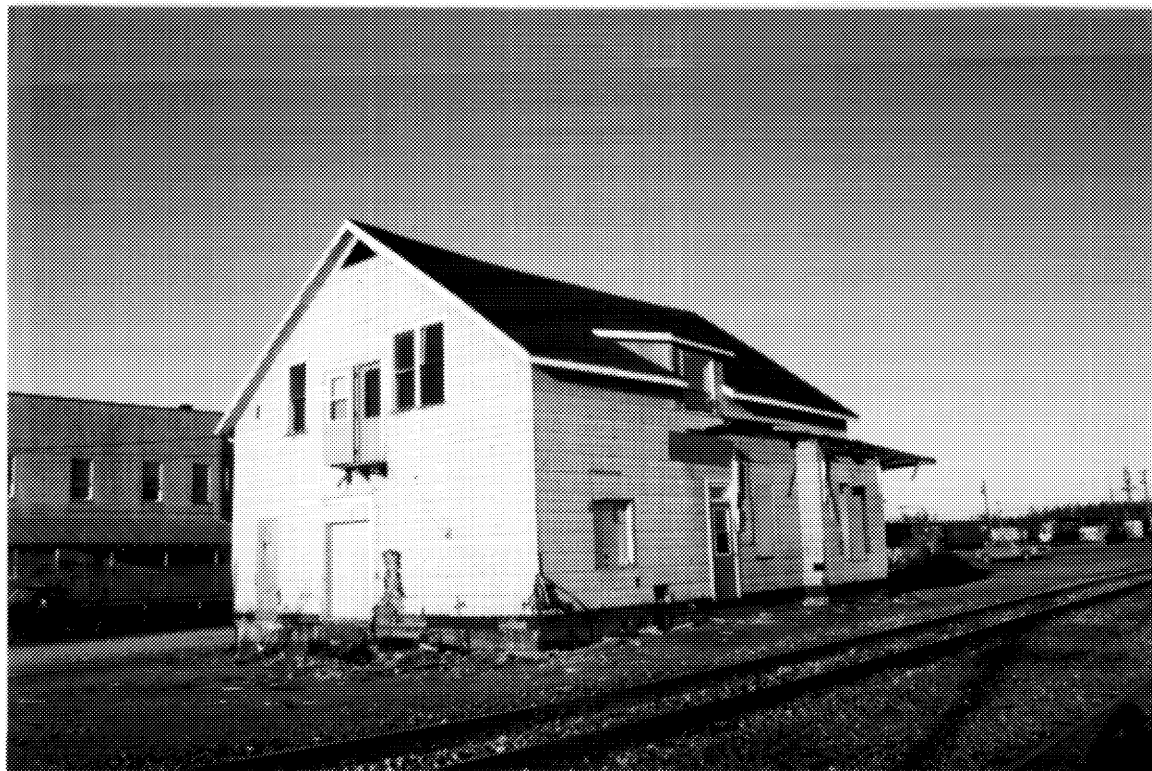
7 Gare de Garneau, construite en 1910. ( Photo: Paul Trépanier, 1993. )
