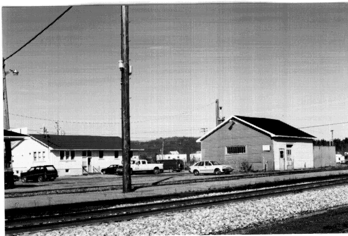
26 Le bâtiment administratif et l'entrepôt à l'ouest de la gare. (Photo: Paul Trépanier, 1993. )
