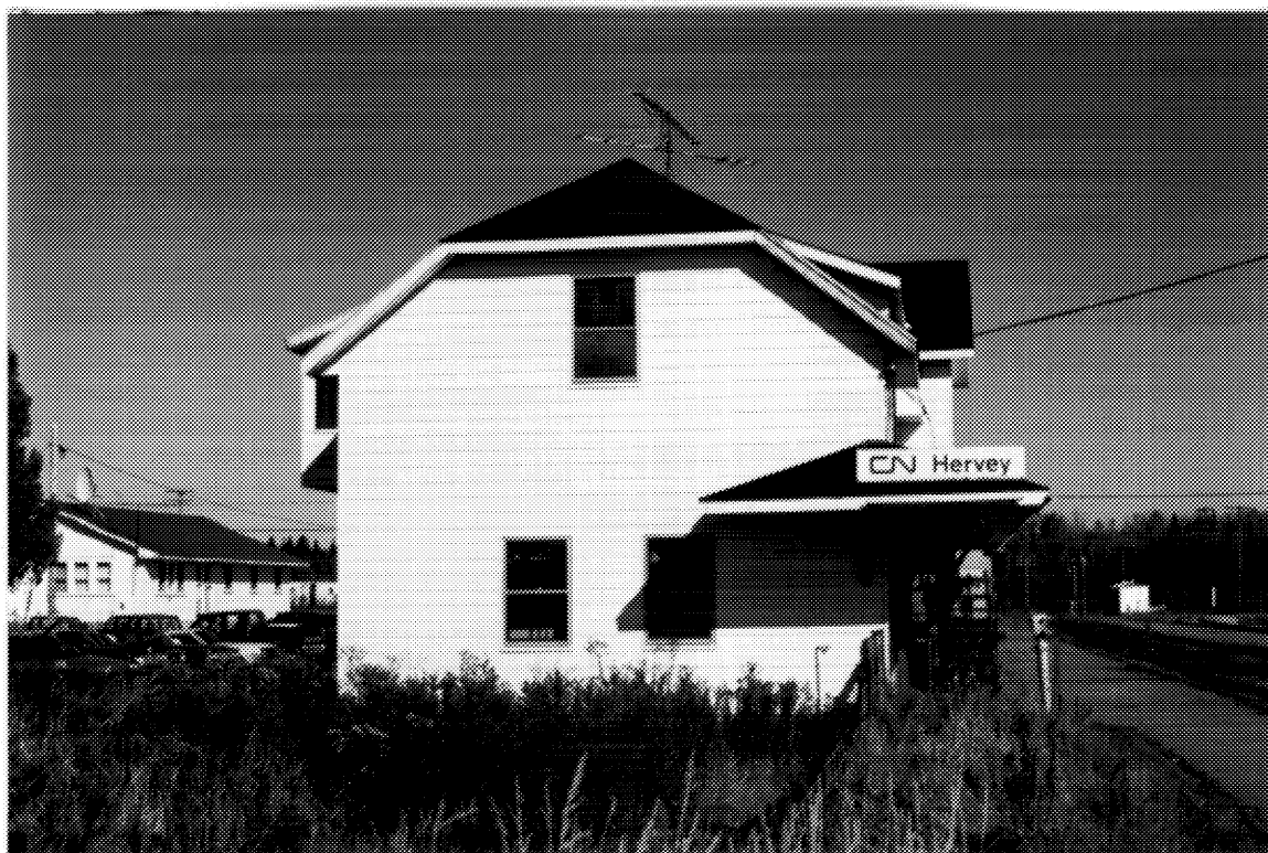
14 Façade latérale est de la gare. ( Photo: Paul Trépanier, 1993. )
