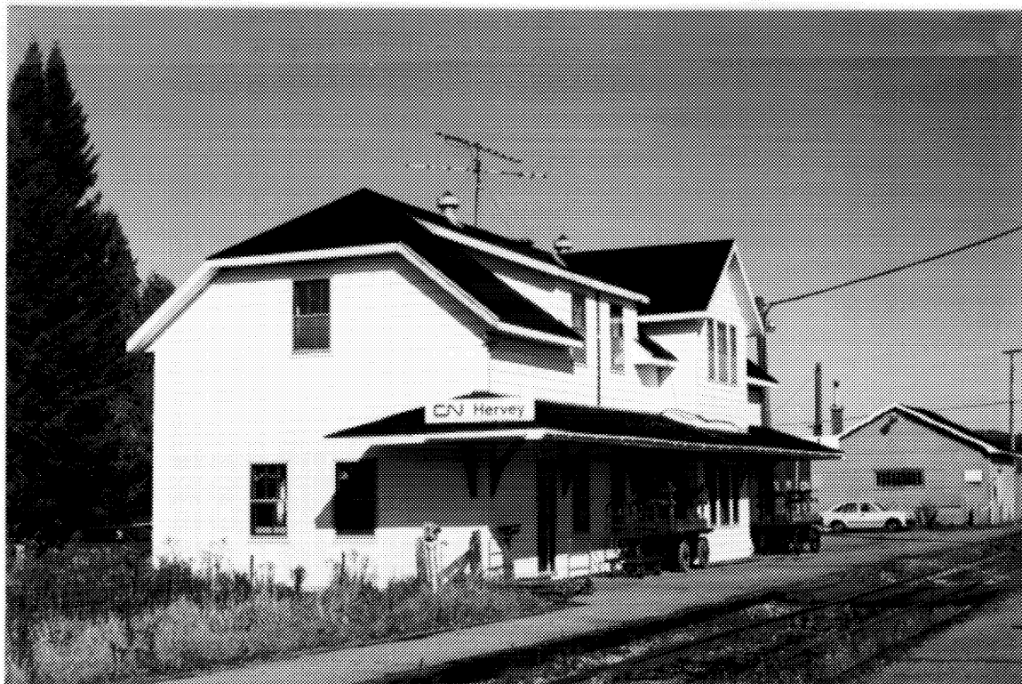
13 Façade est et sud de la gare. ( Photo: Paul Trépanier, 1993. )
