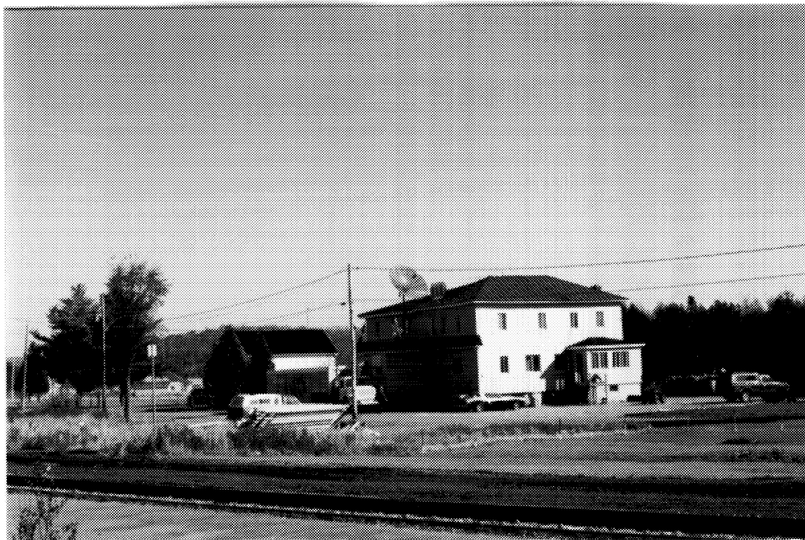
28 L'hôtel et une des résidences que font face à la gare. (Photo: Paul Trépanier, 1993. )
