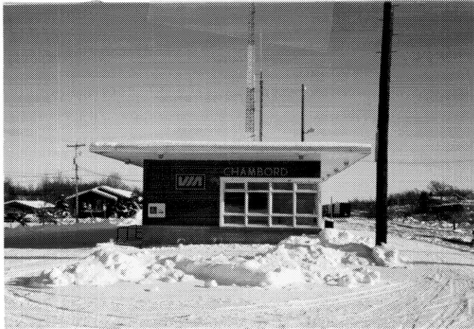
4 Vue de la façade est de la gare. ( Cliché Bergeron Gagnon inc., hiver 1994. )
