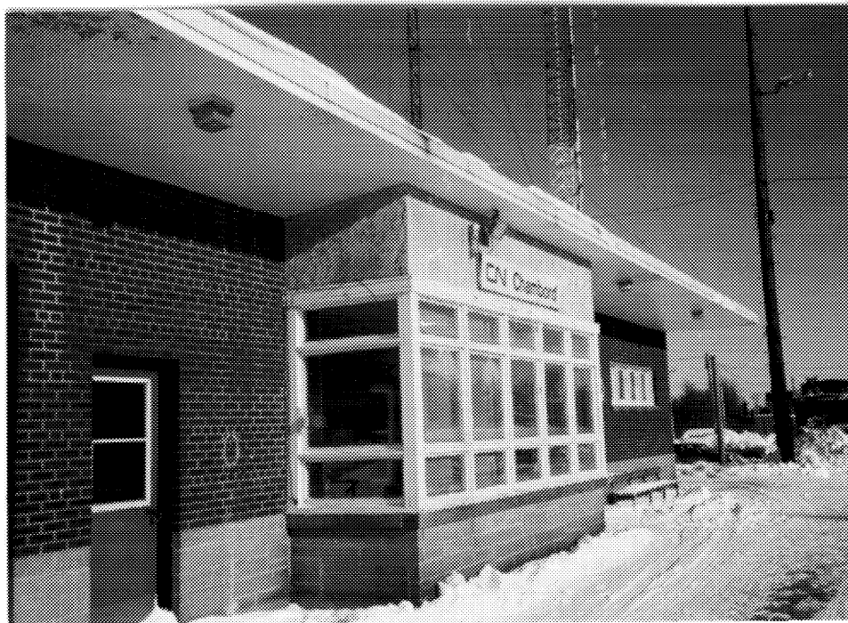
10 Vue de l'oriel (bay-window) du bureau du chef de gare et de l'angle de l'auvent par rapport au mur. ( Cliché Bergeron Gagnon inc., hiver 1994. )
