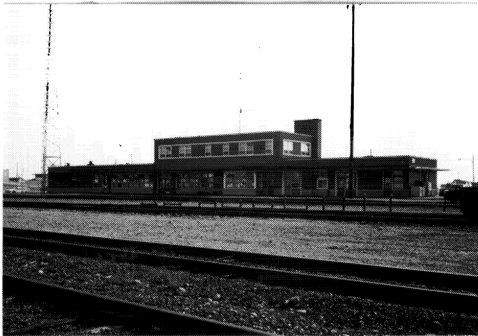
13 Vue de la gare de Senneterre en 1989. (MCCO, nég. no C89.422.31.)
