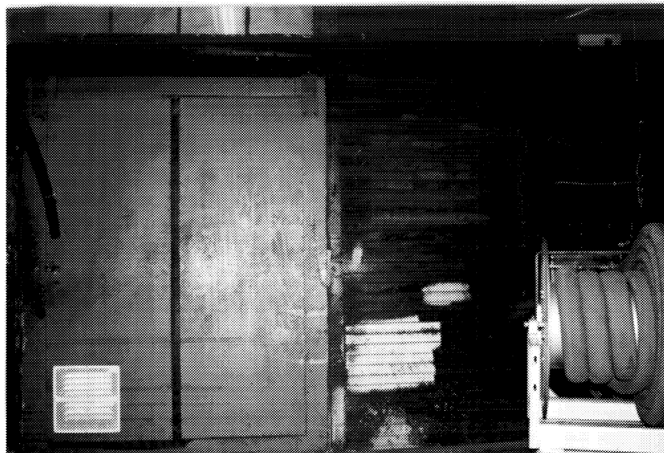
21 Détail de l'ancien entrepôt à bagages et à marchandises. À noter le mur de planchettes de bois embouvetées. (Photographie de Christiane Lefebvre, 1995.)
