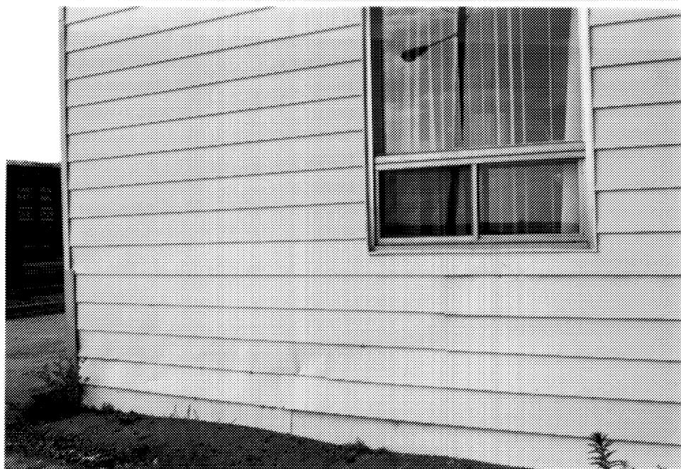
9 Détail des nouvelles fenêtres et du revêtement d'aluminium. (Photographie de Christiane Lefebvre, 1995.)
